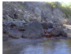
▲アイニンカップ岬周辺の崖崩れ現場
