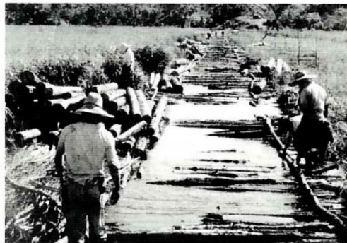
湿地に丸太を並べただけの浮橋(昭和33年)
